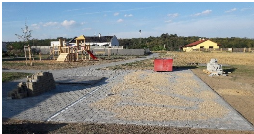
Hasičská základna na radslavičtém hřišti v době přestavby a po opravě.
